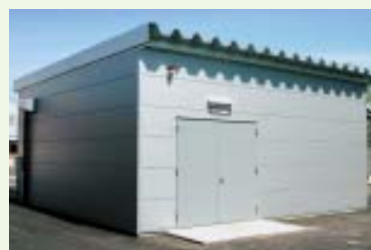
排水処理施設
