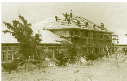
▶酪農短期大学工事（昭和二九年） —旧野幌機農学校の 校舎兼宿舍を改築—
