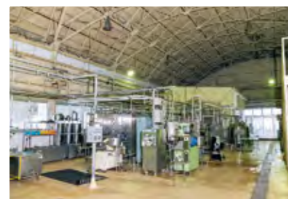
牛乳製造設備は脱臭処理工程が入ることで生乳本来の風味を残すことを実現
